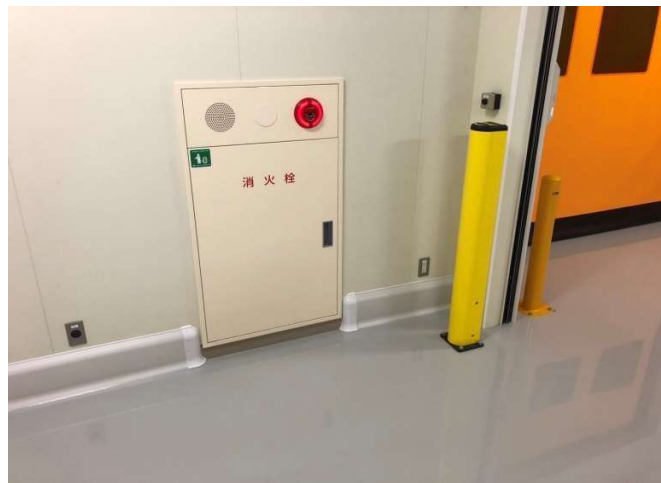
ガードポール (GRD150) + R巾木 (KS200) 設置
