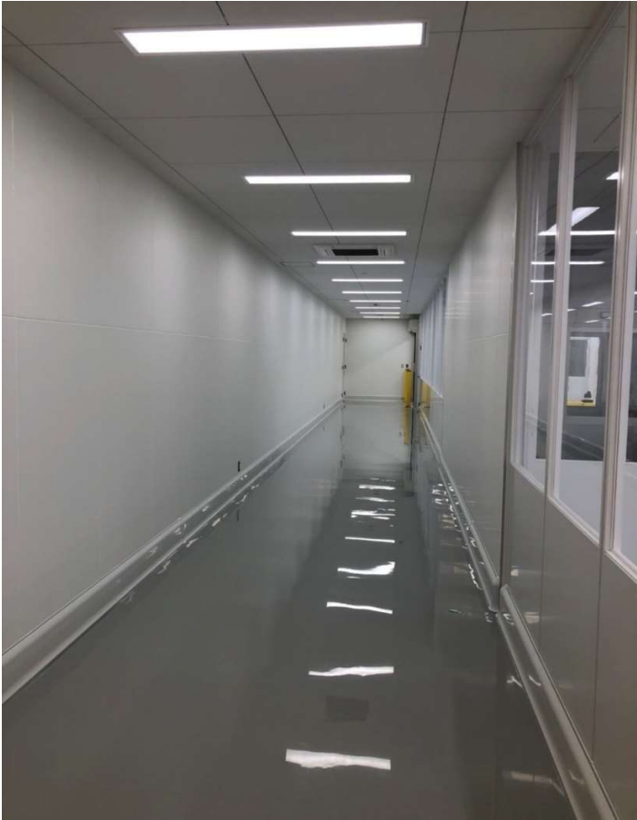
R巾木 (KS200) 設置
